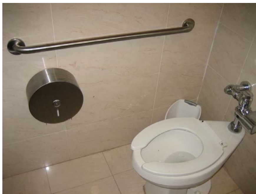
Figura 1. Cubículo adaptados en servicio sanitario para las personas con discapacidad en Centro Comercial.
