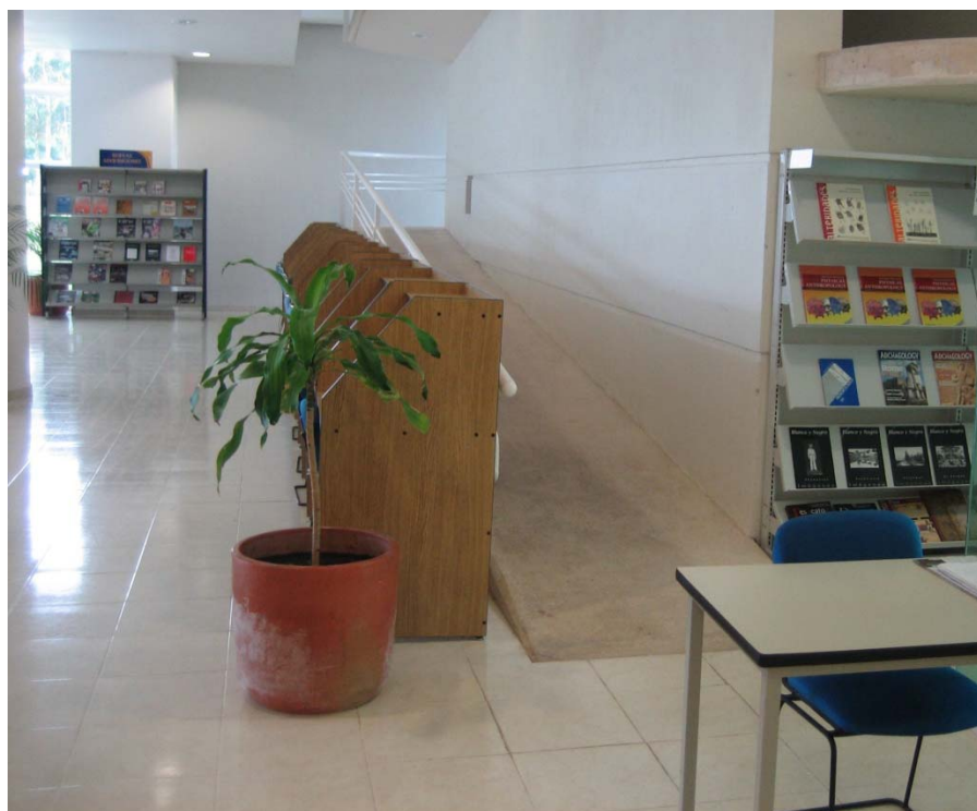
Figura 5.- Rampa para cambiar de piso en Biblioteca Pública.
