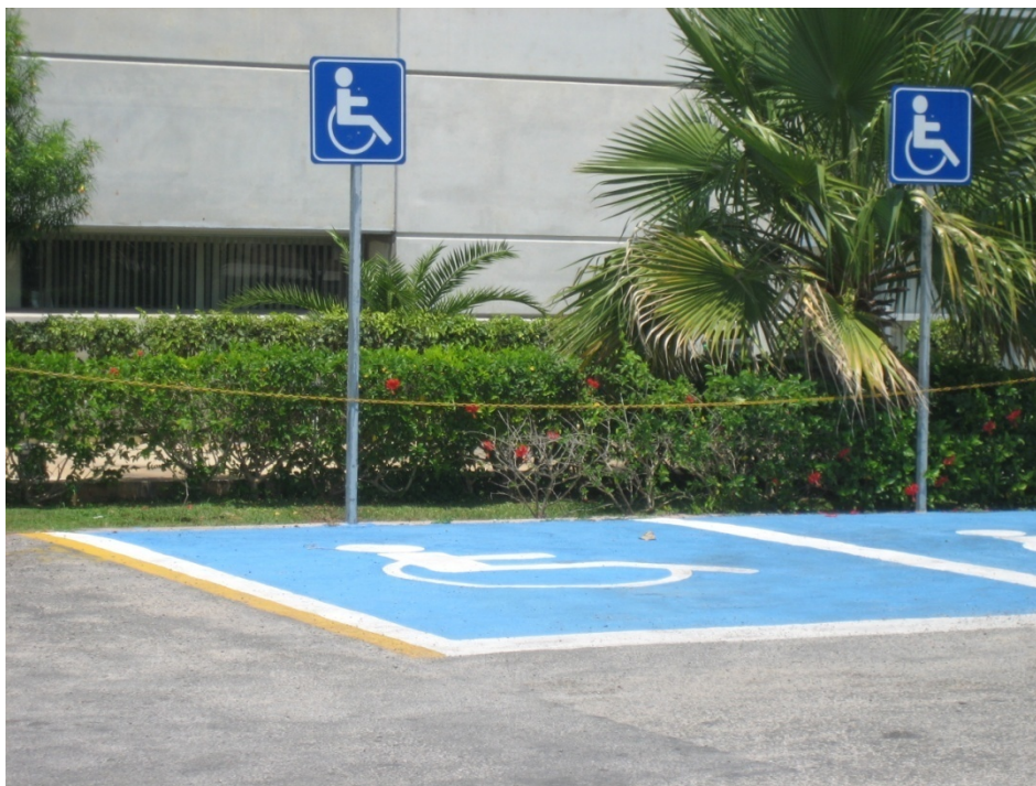
Figura 4. Cajones de estacionamiento exclusivos con señalización de poste con el símbolo internacional de accesibilidad en el Edificio Administrativo de Gobierno.
